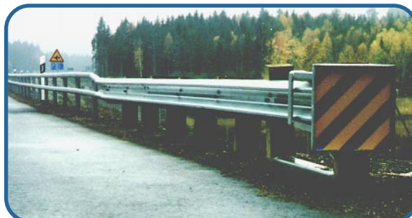
Bild 4 Övergång till energiabsorberande räckesavlut.
